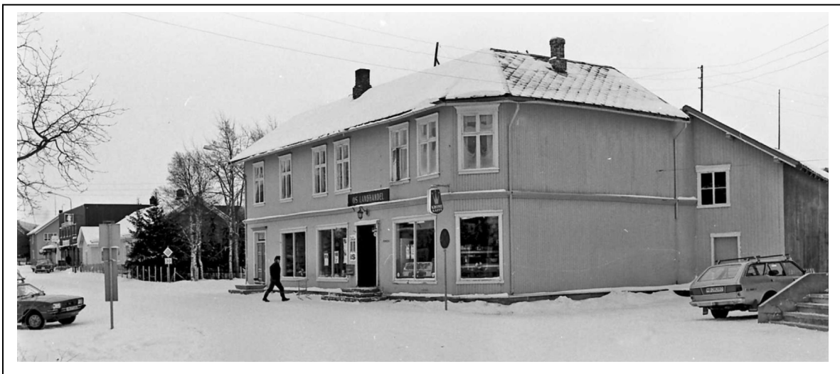
Figur 2.16: Den gamle landhandelen før den ble revet på slutten av 1970-tallet (kilde: Musea i Nord-Østerdal/digitalt museum).
