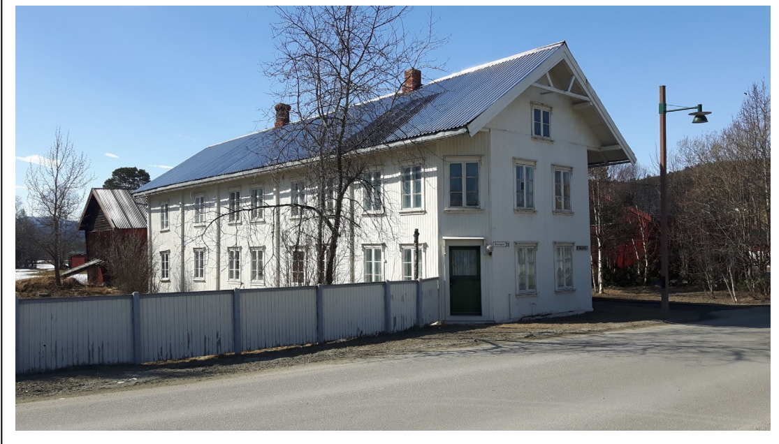
Figur 6.3: Gjelten, hovedbygningen på Sundet Søndre, sett fra Brutippen, med sine karakteristiske 45-graders innganger mot gata.
