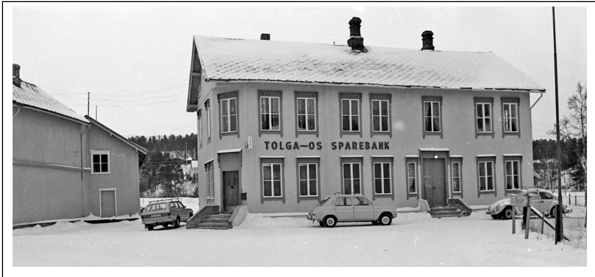
Figur 2.15: Det gamle bankbygget før det ble revet på slutten av 1970-tallet (kilde: Musea i Nord-Østerdal/digitalt museum).
