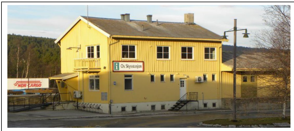
Figur 6.6: Stasjonsbygningen fra 1958. Representativ seinfunksjonalisme.
