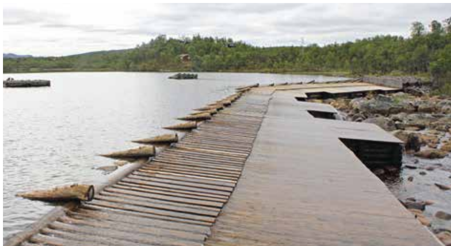
Djupsjødammen ved Djupsjøen i Hitterelva
