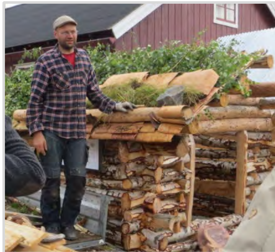
Figur 2.1: Kolbjørn Vegar Os viser tradisjonell takteking med never og torv på ei bjørkeløe. Tradisjonshåndtverk er en viktig del av kulturminnevernet.
