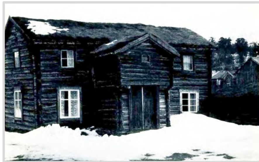
Figur 8.16: Barfrøstua på Bakken østre. Denne ble bygd før 1852. Påbygd 2. etasje mellom 1851 og 1880. Vinduene i første etasje er skiftet ut inn på 1800-tallet. Foto: Amund Spangen
