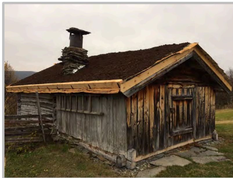
Figur 6.7: I 2017 ble det lagt nytt tak på Kokhuset. Foto: Randi Brænd
