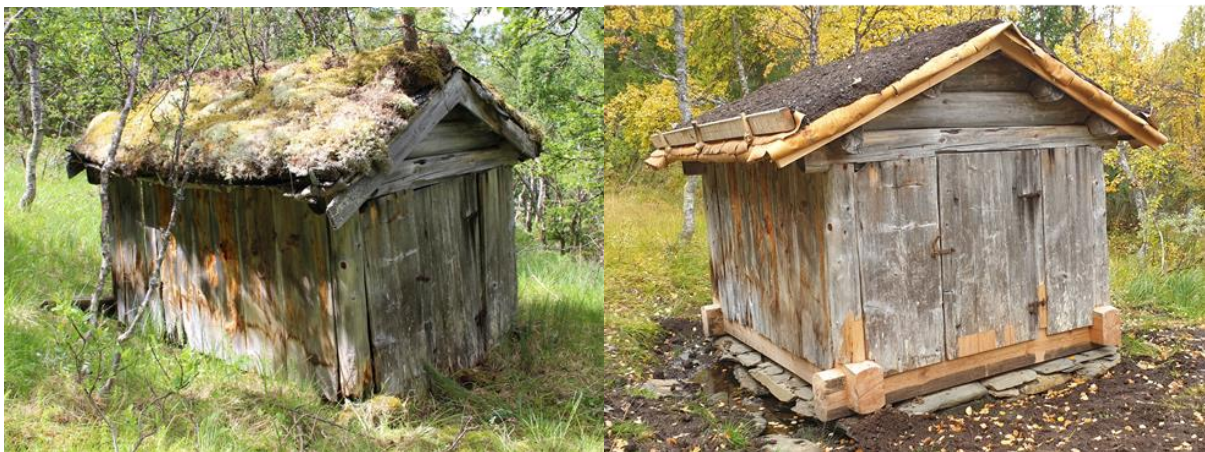
Ei mjølkeavkjøling før og etter restaurering, Håkonsvollen, Kjurrudalen. Taktekking og utskifting av materialer må utføres fagmessig, men fjerning av torv rundt veggene og trær på taket, samt grøfte bort vann kan de fleste gjøre selv. Foto: Berit Siksjø.
