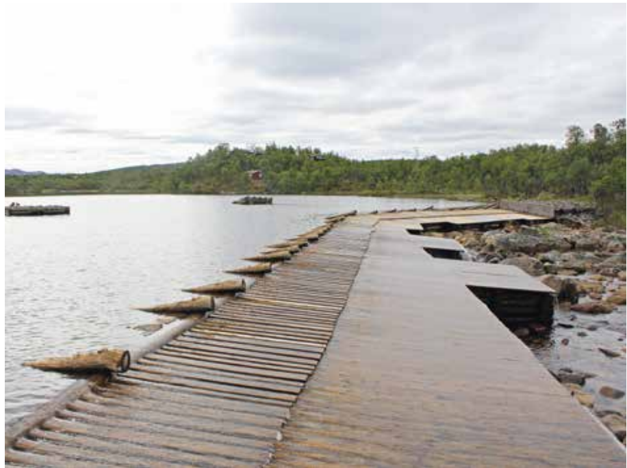
Djupsjødammen ved Djupsjøen i Hitterelva
